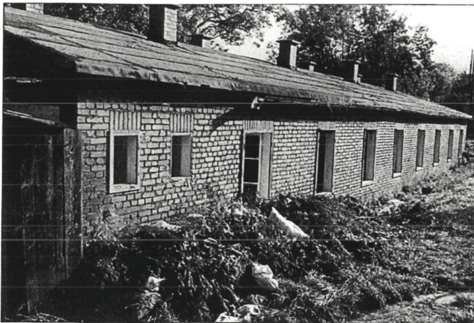
Das angemietete Abbruchobjekt in der Joh.-Sackl-Gasse in Donawitz vor dem Umbau.
