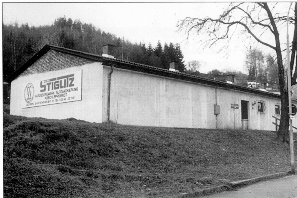
Das Schützenhaus nach der Fertigstellung
